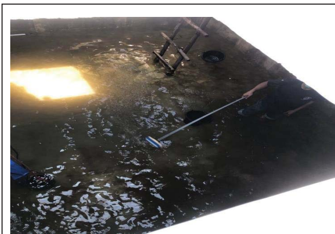
รูปที่ 3.3.3-4 การล้างทำความสะอาดถังเก็บน้ำ
