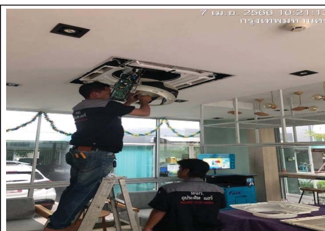
รูปที่ 3.3.10-3 ทำความสะอาดเครื่องปรับอากาศ
