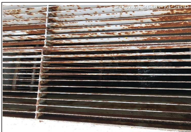
รูปที่ 3.1.5-4 ตะแกรงดักมูลฝอยบ่อสุดท้าย
