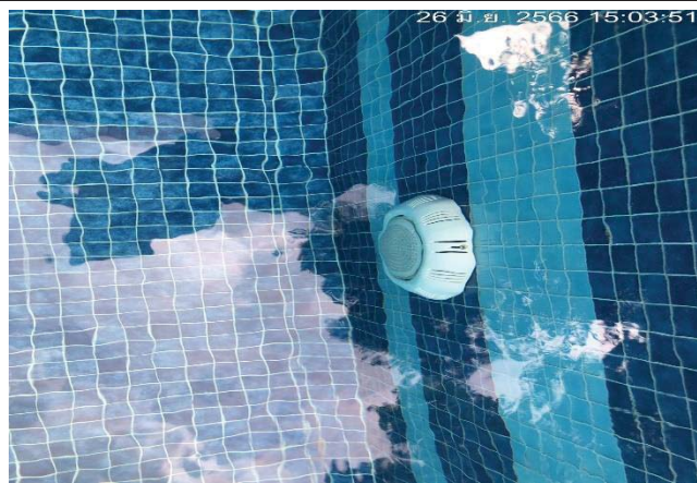
รูปที่ 3.4.3-1 หลอดไฟสระว่ายน้ำ
