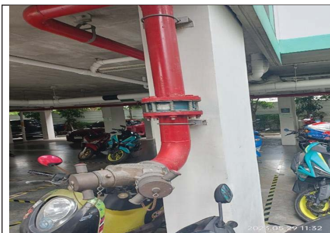
รูปที่ 3.3.9-7 หัวรับน้ำดับเพลิงอาคาร C
