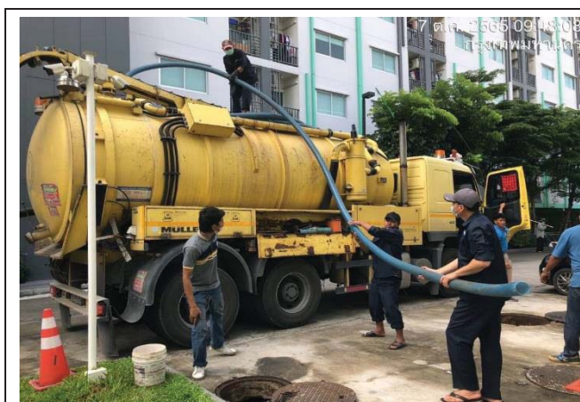
รูปที่ 3.1.5-6 สูบตะกอนบ่อบำบัด
