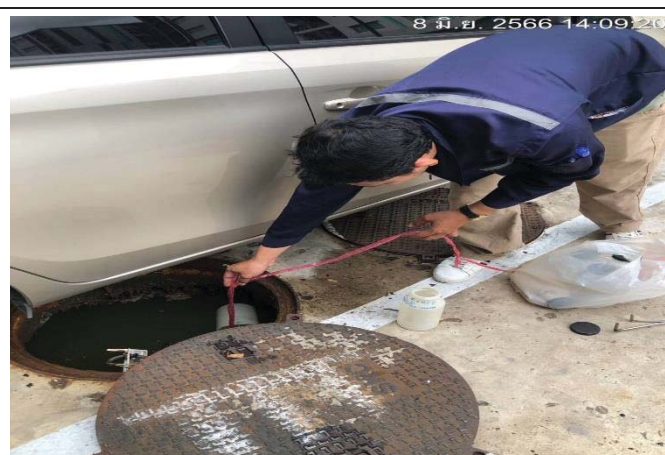
รูปที่ 3.1.5-3 เก็บตัวอย่างน้ำเสียเพื่อตรวจสอบ
